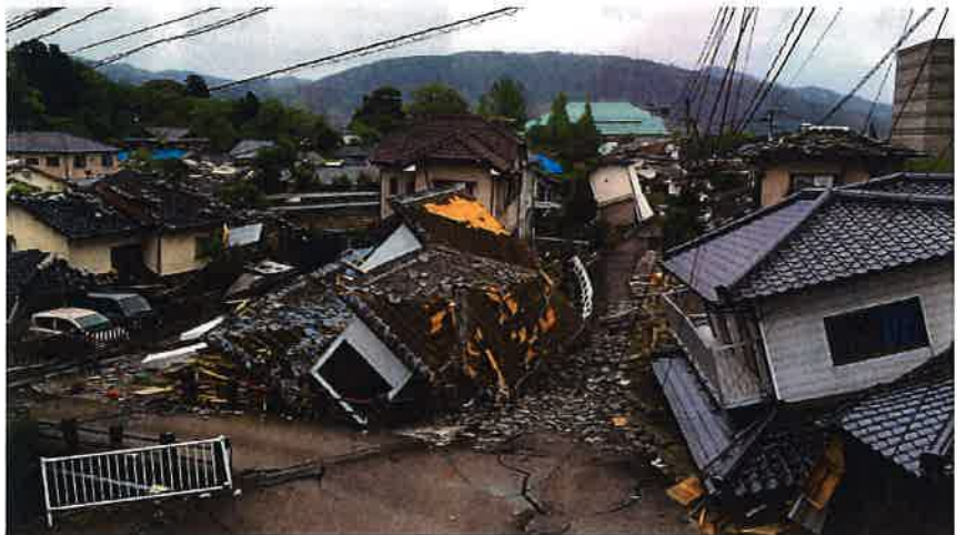
地震により倒壊した益城町(熊本県上益城郡益城町)
