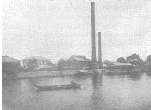
●大手町火力発電所(現中電病院位置)
